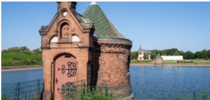
Schaufilterbecken Wasserkunst, Foto: Kraft/ Angerer
