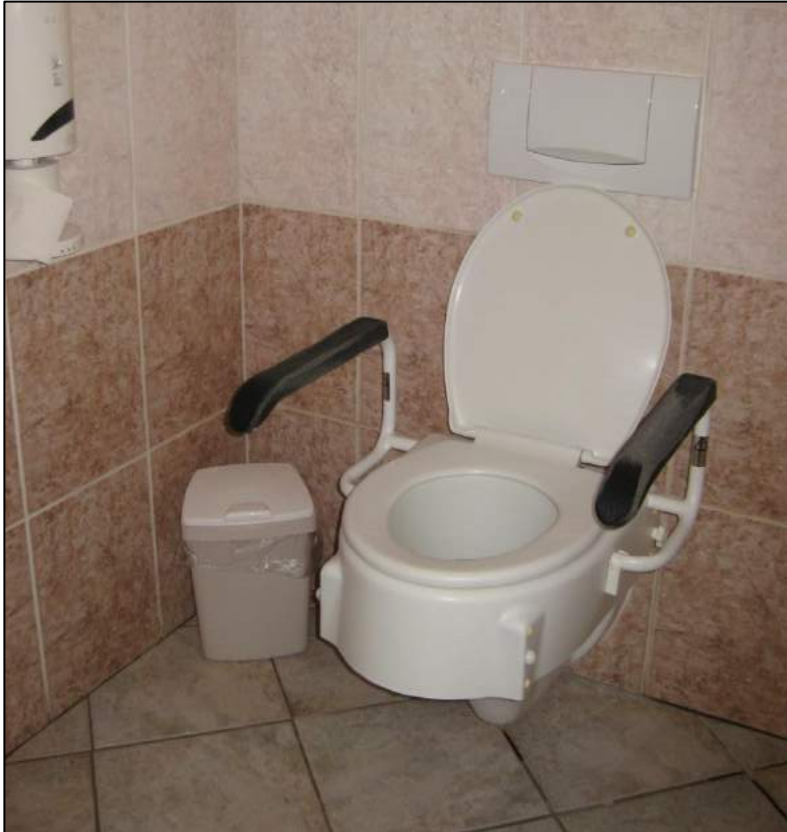
Abbildung 8: Toilettenkabine im Damen - WC mit mobiler Sitzerrhöhung im Restaurant Appelbeck am See (Foto: Düren 2014)
