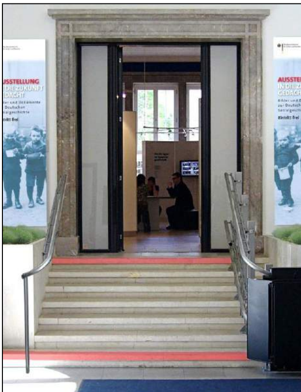
Abbildung 49: Praxisbeispiel für kontrastreiche Treppenstufen (Foto: NatKo 2012)
