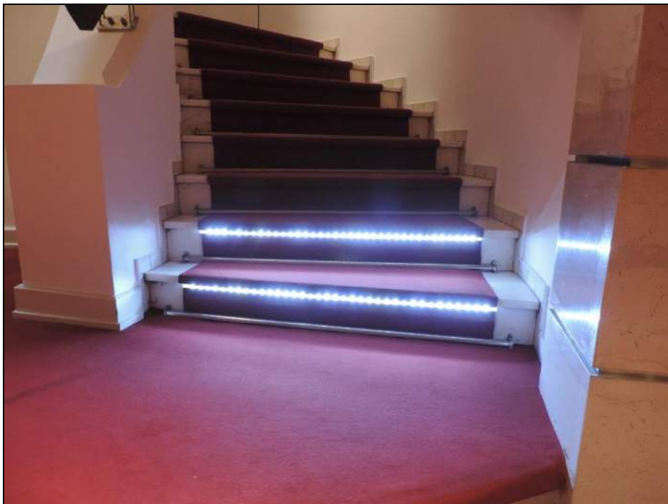
Abbildung 10: Leitstreifen (Licht) an den Treppen im Untergeschoss (Foto: Düren 2014)
